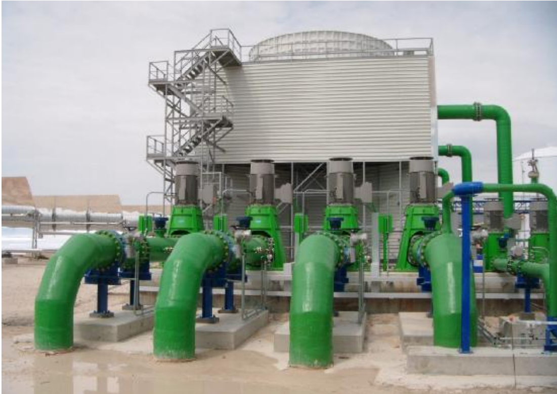
Fotografía obras especiales en PRFV
