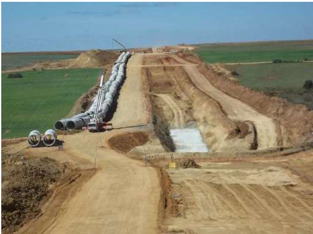
Tubería de hormigón armado con camisa de chapa
