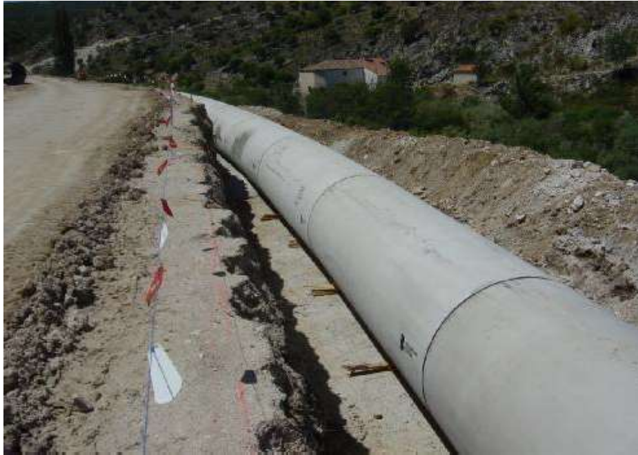
Fotografía montaje en obra
