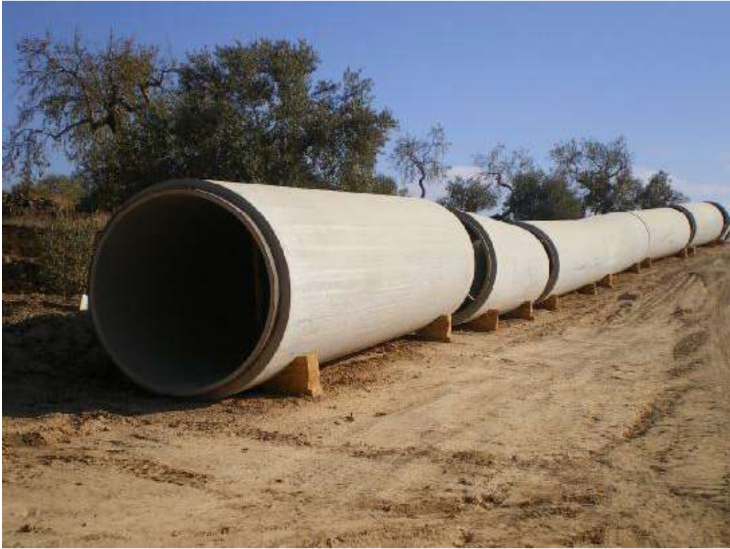
Fotografía de acopio tubos
