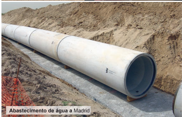
Junta elástica dupla para tubos de betão
