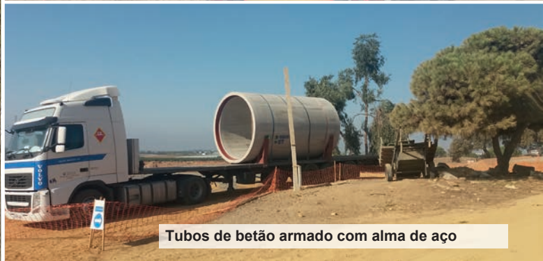
Transporte de tubo de betão com alma de aço
