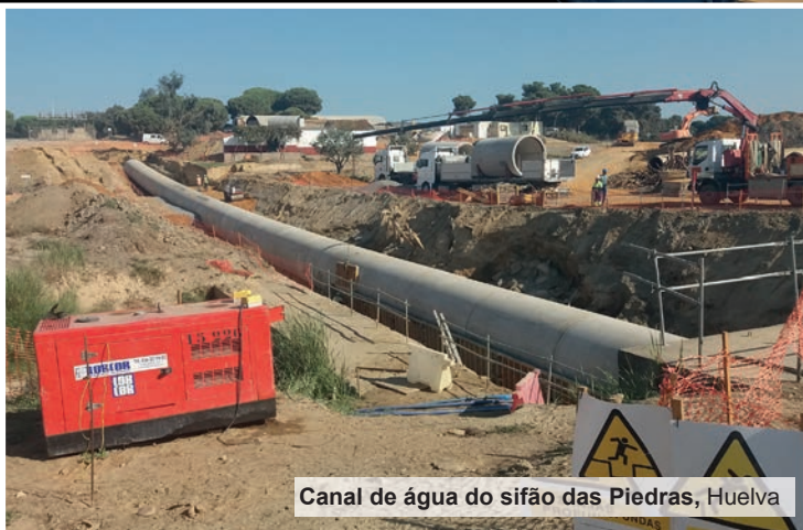
Instalação de tubo de betão pre-esforçado com alma de aço
