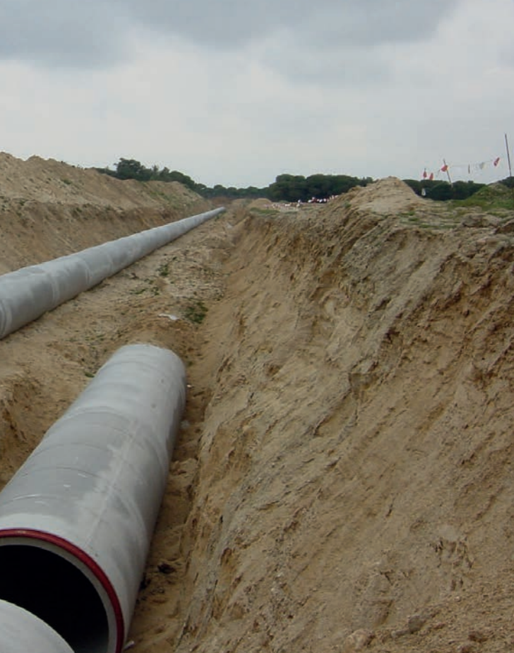
Transporte de tubo de betão com alma de aço
