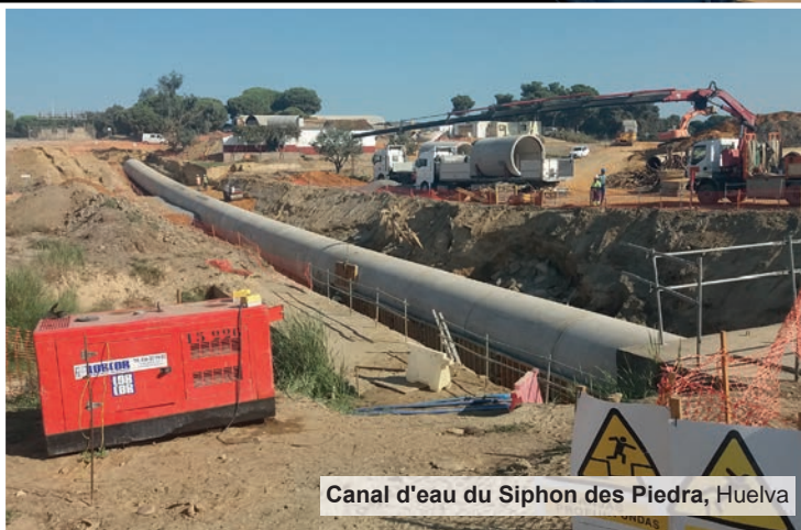
Pose de tuyaux en béton précontraint ame tôle
