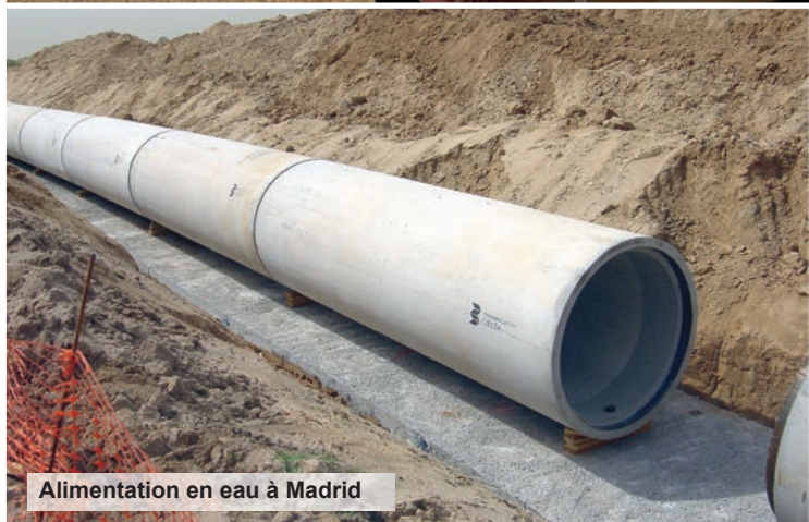
Tuyau en béton à double joint élastique
