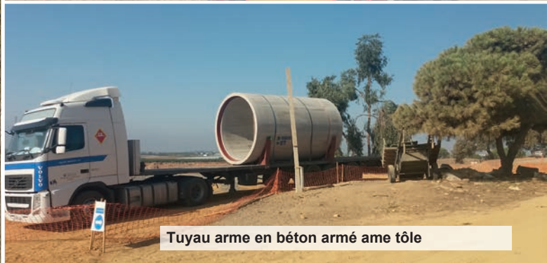
Transport de tuyaux en béton ame tôle
