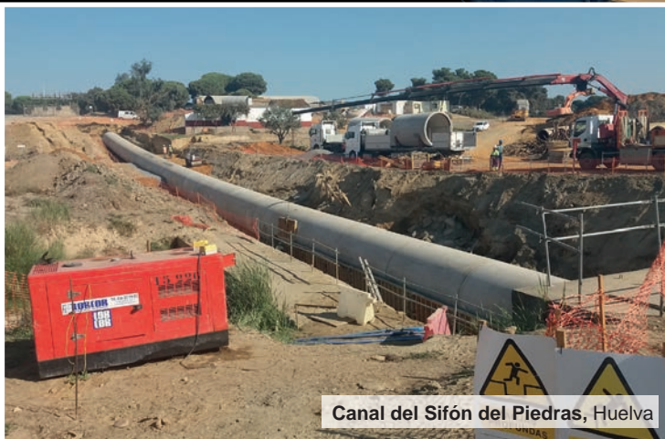
Montaje tubería de hormigón postesado con camisa de chapa
