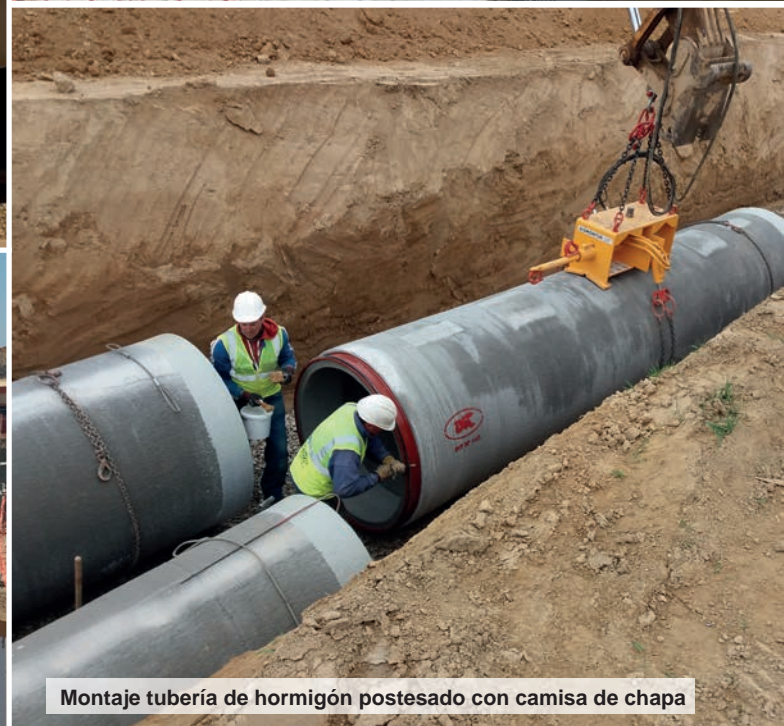
Canal del Sifón del Piedras, Huelva
