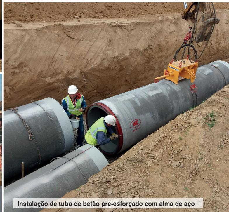
Instalação de tubo de betão pre-esforçado com alma de aço
