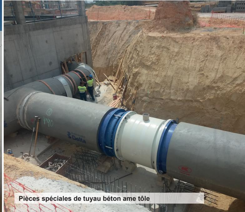
Pièces spéciales de tuyau béton ame tôle
