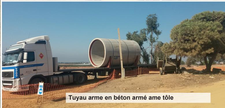
Tuyau arme en béton armé ame tôle
