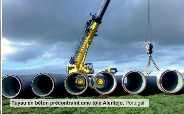
Tuyau en béton précontraint avec tôle Alentejo, Portugal
