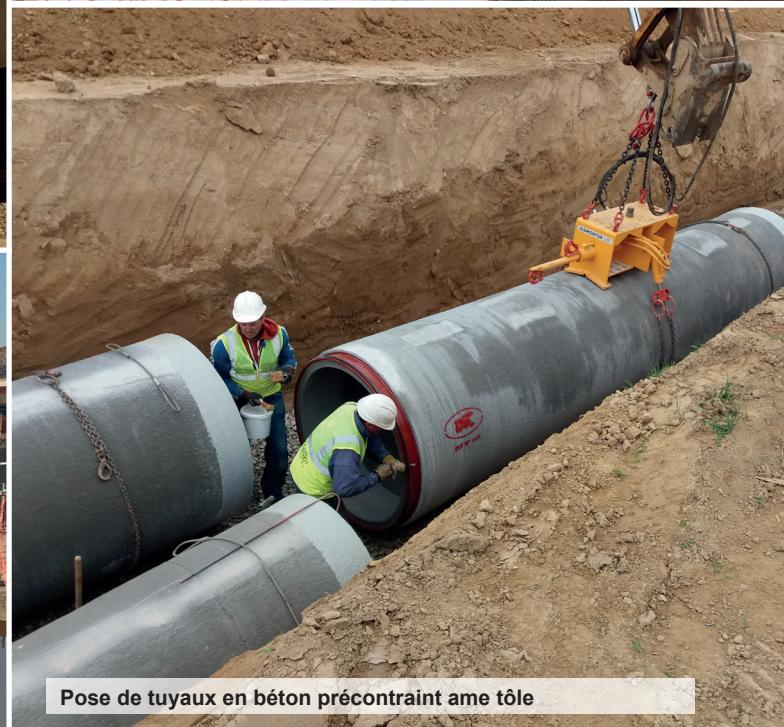
Pose de tuyaux en béton précontraint ame tôle
