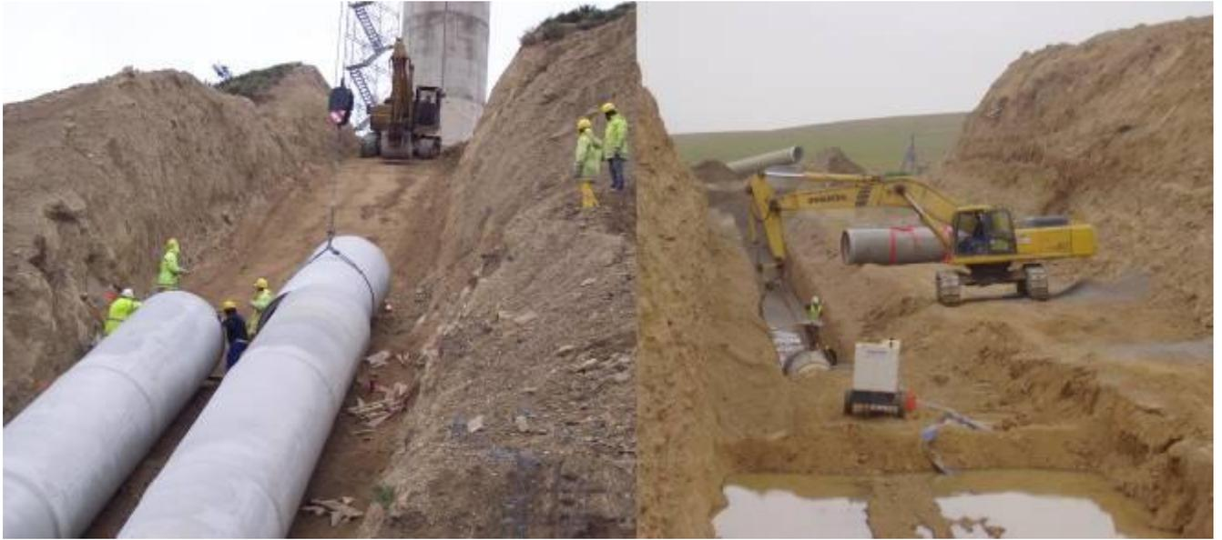
**FOTO 2. Montaje de una impulsión de gran pendiente y la salida de una balsa de riego.**
