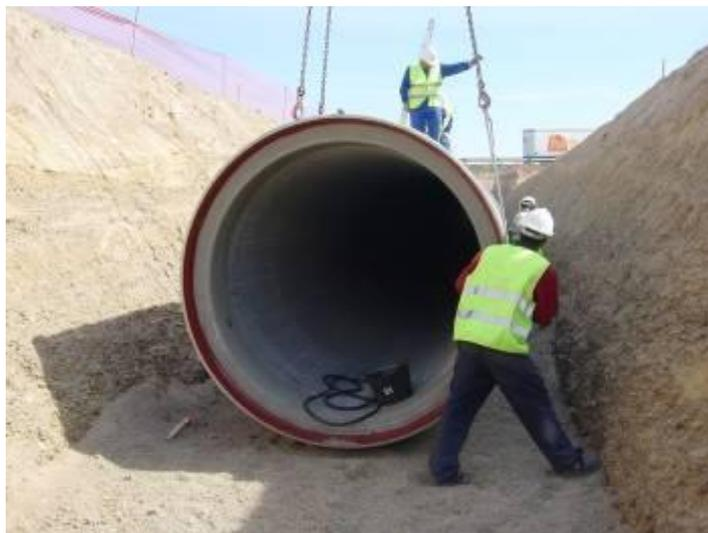
**FOTO 3. Tubería de hormigón postesado con camisa de chapa**
