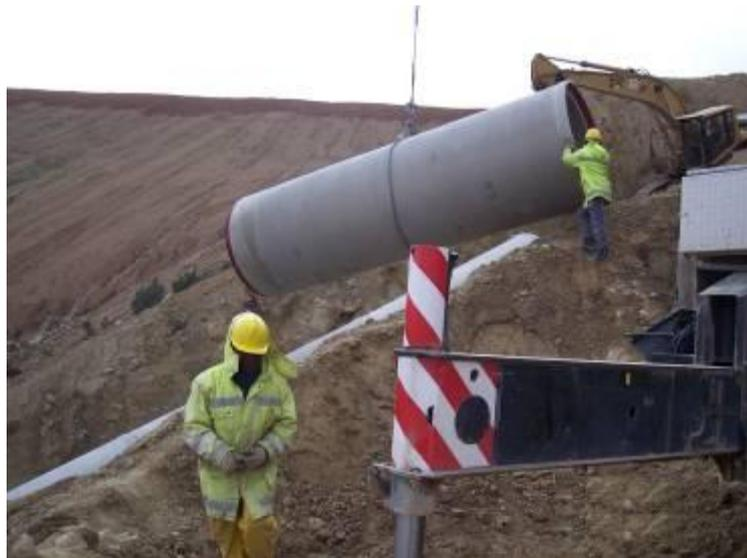
**FOTO 1. Montaje de tubería en zona de gran pendiente**
