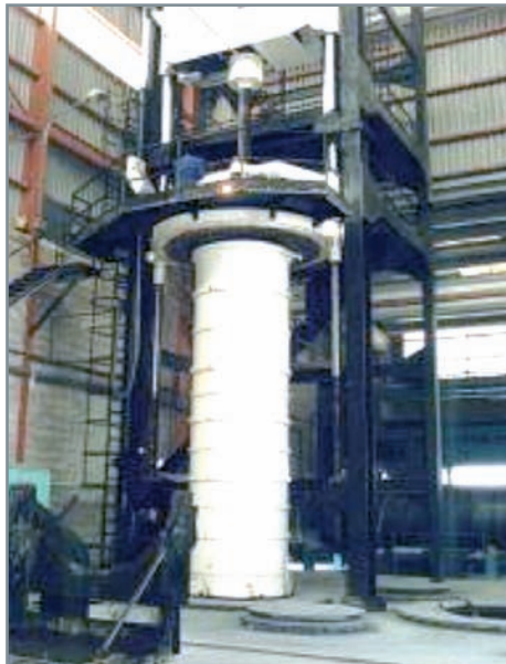
■ Turbomaster, hormigonado del núcleo por compresión radial.
