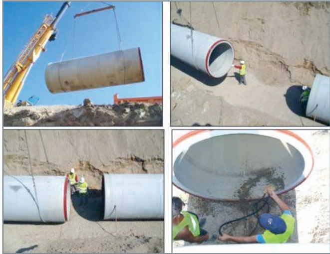
■ Proceso de montaje.
