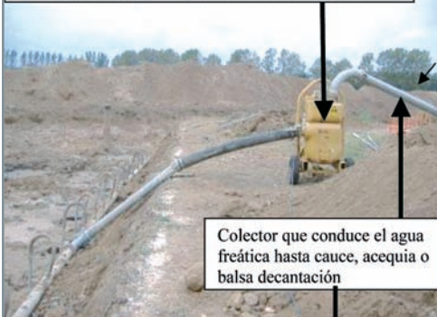
Bomba que aspira agua freática desde lanzas al colector.
