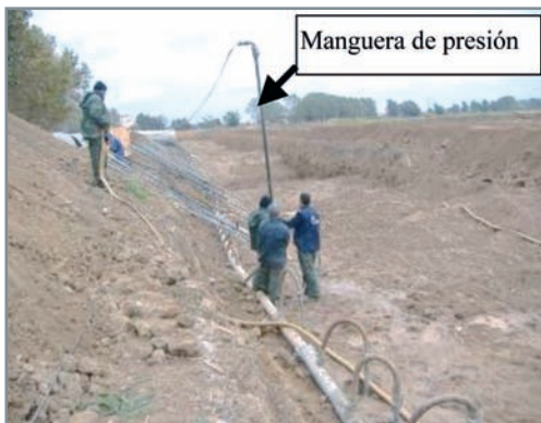
Introducción de la lanza en el terreno.
