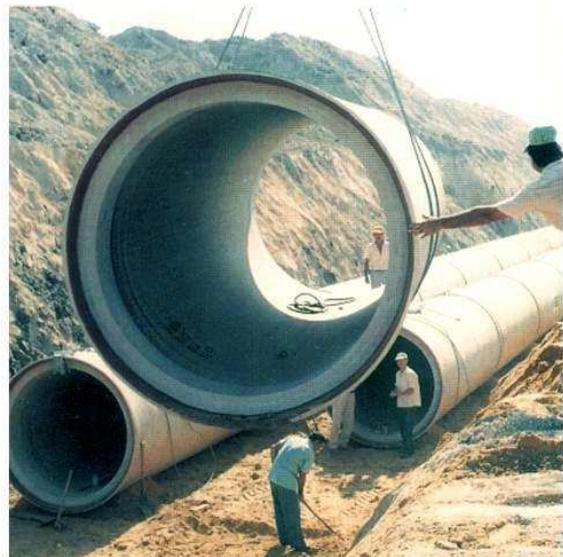
**Montaje Tubería de Hormigón Postesado con camisa de chapa y junta elástica**
