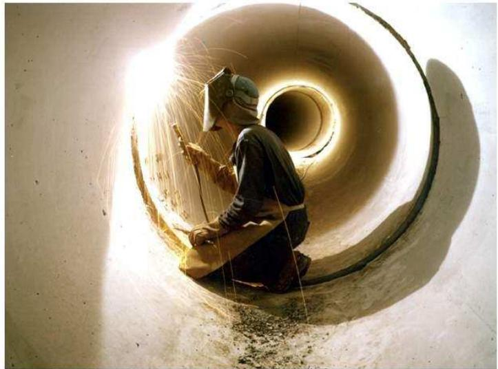
**Soldadura interior de junta.**
