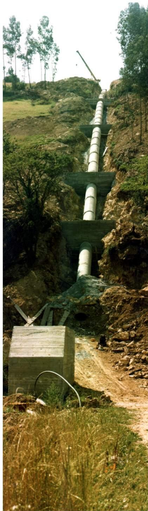
Montaje de Tubería en zona de fuerte pendiente.
