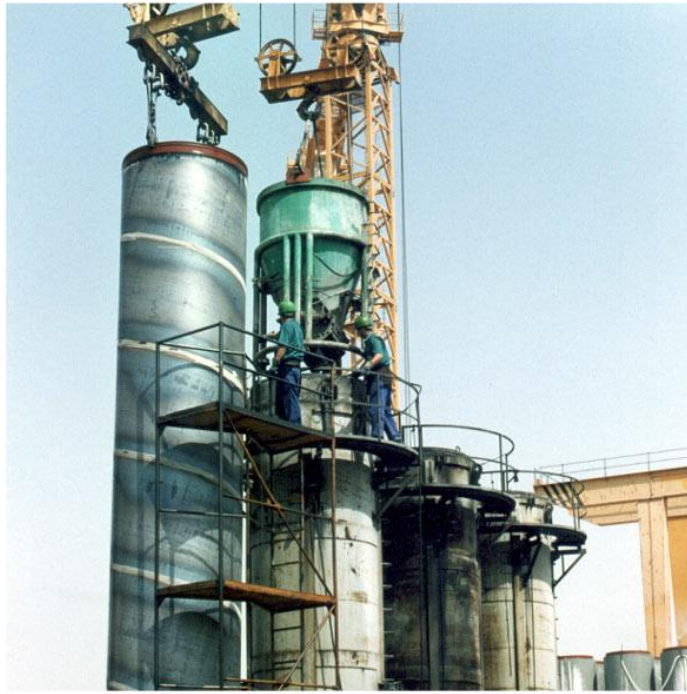
Hormigonado de la tubería
