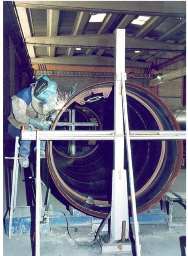
Soldadura del cabezal a la camisa
