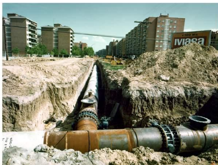
Montaje en obra de piezas especiales.
