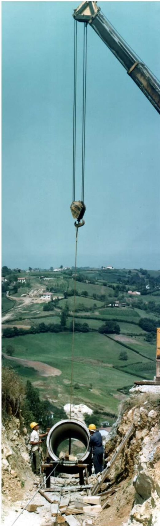
Montaje de Tubería en zona de fuerte pendiente.
