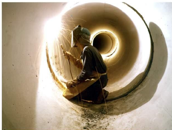
Montaje de Tubería de Hormigón Postesado con camisa de chapa y Junta Elástica.
