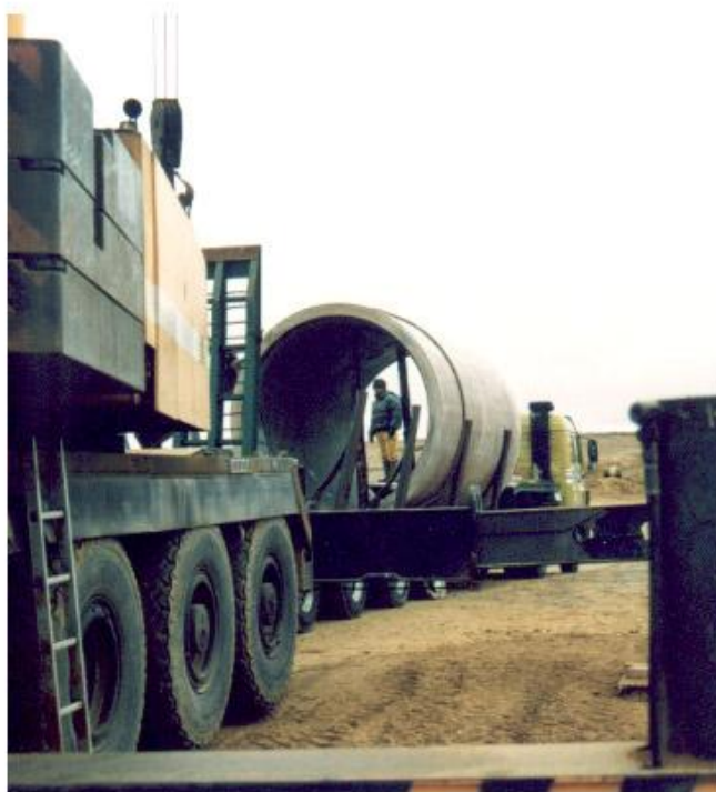
Tubería de Hormigón armado con camisa de chap a de diámetro 2500 mm.
