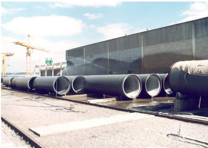
Curado del revestimiento mediante riego por aspersión.
