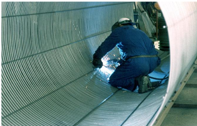
Colocación de separadores en la armadura
