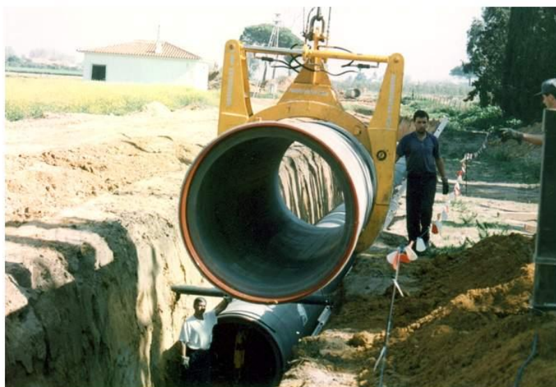
Montaje de Tubería de Hormigón Postesado con camisa de chapa y Junta Elástica.
