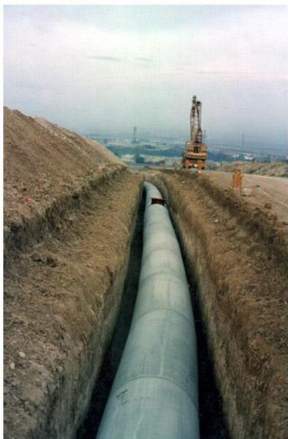
Montaje de tubería de Hormigón armado con camisa de chap a
