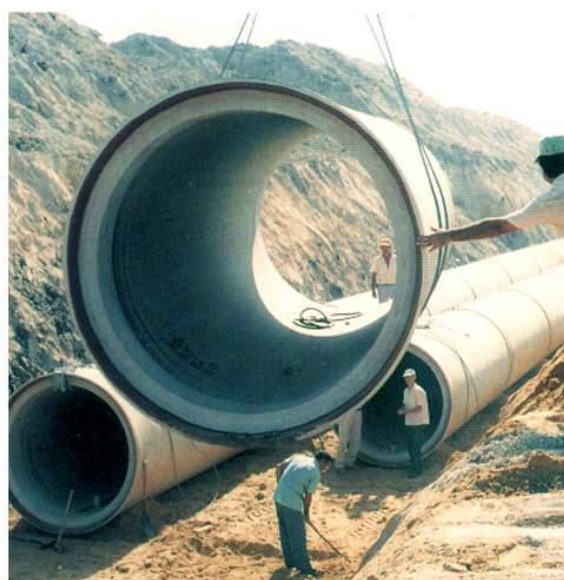
Montaje Tubería de Hormigón Postesado con camisa de chapa y junta elástica
