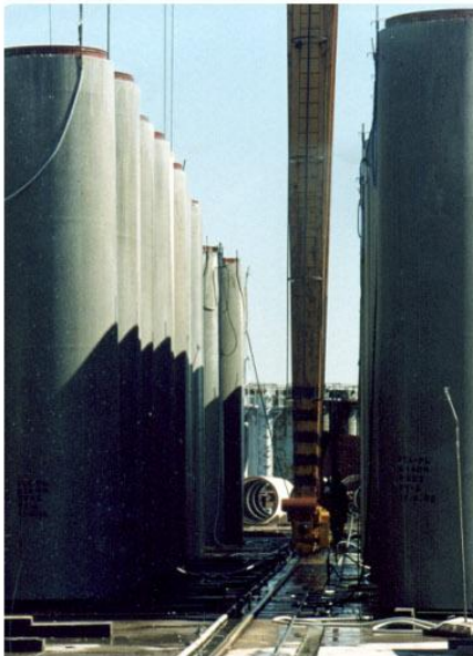
Curado de la tubería mediante riego.
