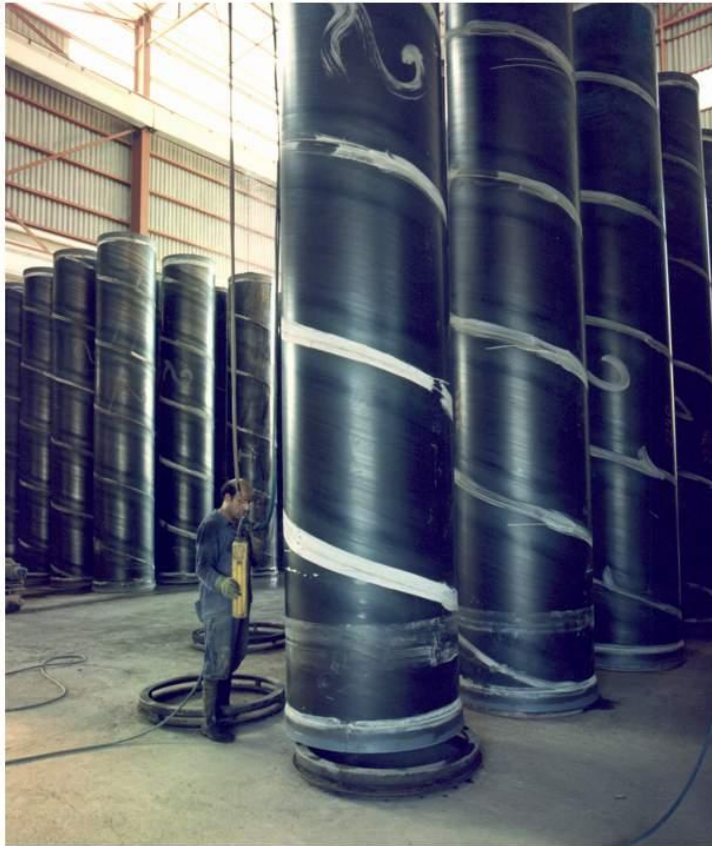
Colocación camisa sobre base de hormigonado
