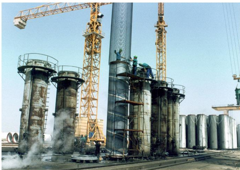
Colocación de armadura exterior
